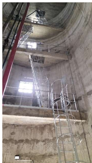
Nouvelles échelles et nouveaux gardes corps
