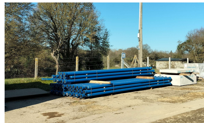
Stockage de canalisations fonte lors d'un chantier de renouvellement
