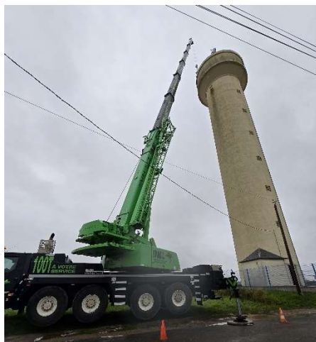
Installation de gardes corps sur dôme
