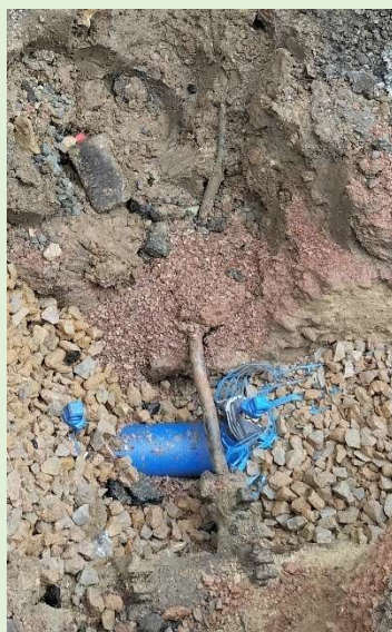
Suppression d'un branchement plomb
