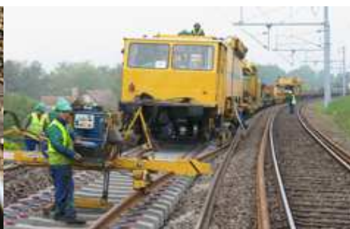
Figure 12: Longs Rails soudés sur traverses béton
